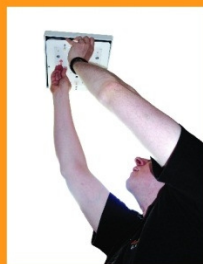
7. Geräteträger anschrauben.
