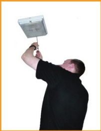
1. Stromversorgung ausschalten und Diffusor abschrauben.
