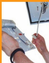
5. Steckverbindung abziehen und Geräteträger entfernen.
