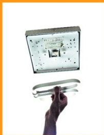
3. Lampen entfernen.
