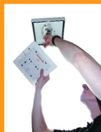
6. Neuen Geräteträger mit der Steckverbindung verbinden.
