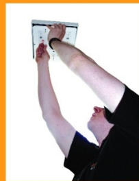
4. Geräteträger abschrauben.
