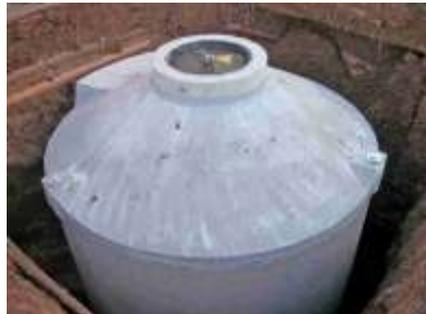
Der einbaufertige Mall-Pufferspeicher Solitherm wurde direkt vom Lieferfahrzeug in die vorbereitete Erdgrube abgesetzt.
