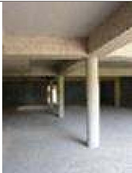
Gegründet wurde der Neubau auf einem ehemaligen Wingert. Statische Gründe erforderten eine Stahlbetonkonstruktion des Basisgeschosses, zur sicheren Lastaufnahme der vertikalen und horizontalen Lasten. Auf dem mächtigen Unterzug über den Säulen, ruhen die Lasten der aufgehenden Außenwand.
