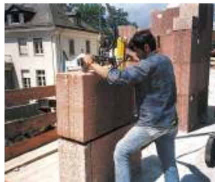
1998 wurde bei Bisootherm ein weiterer Fortschritt eingeführt – CAD-Anlagen und Steinsägen. Vorkonfektioniert und passgenau, erhielten vor 12 Jahren schon die Bauunternehmen Planelemente aus dem Hause Bisootherm, just in time auf die Baustelle.
